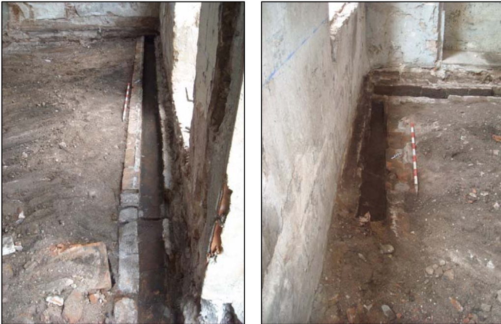
Vista general dels dos trams de canalització UE 105 i 108
