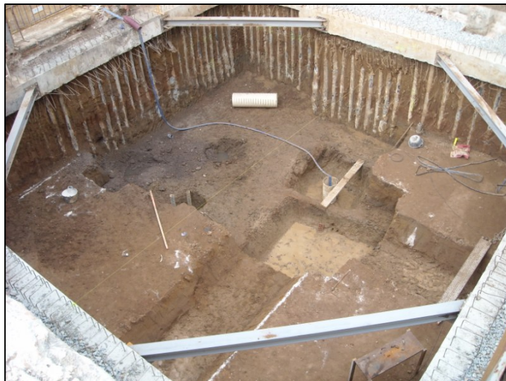
Vista general del final de l'excavació del soterrani de la Nau 2
