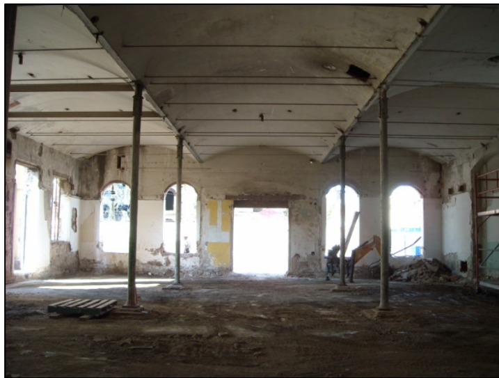
Vista general l'interior de la Nau 2 un efectuat el primer rebaix general
