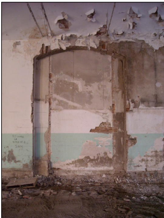
Detall de la porta cegada situada a l'extrem nord del parament nord-oest de la Nau 3
