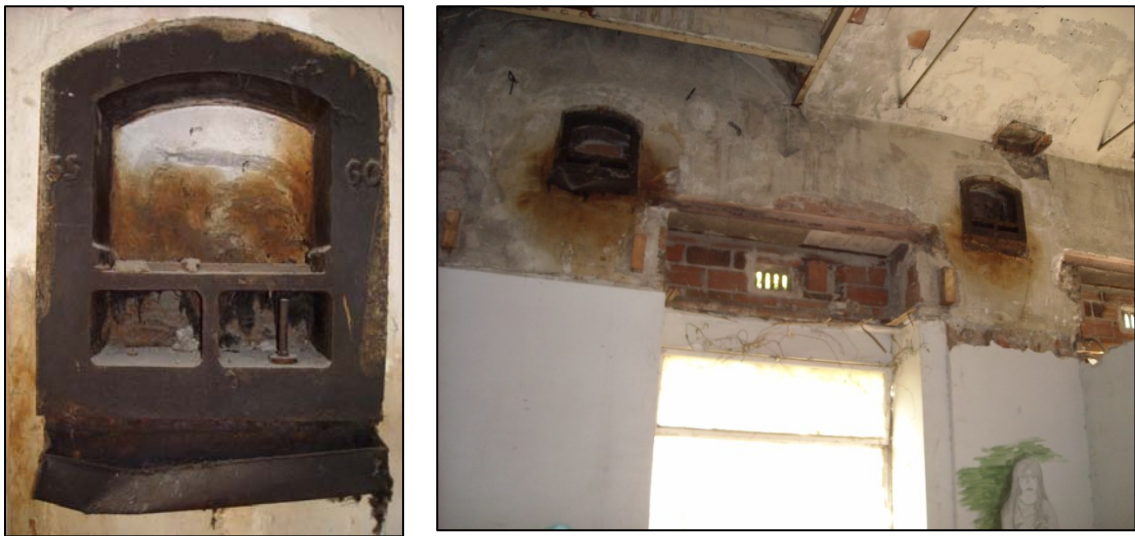
Detall i vista general de les fornícules localitzades a la Nau 3
