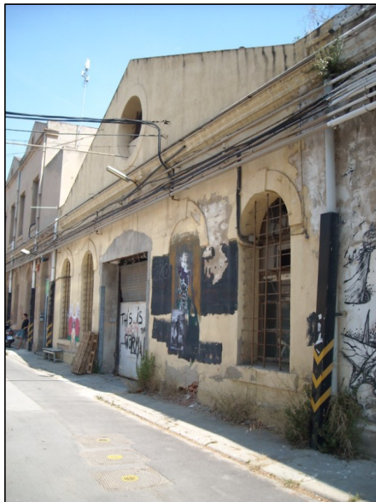
Vista general de la façana de la Nau 2 abans d'iniciar-se els treballs
