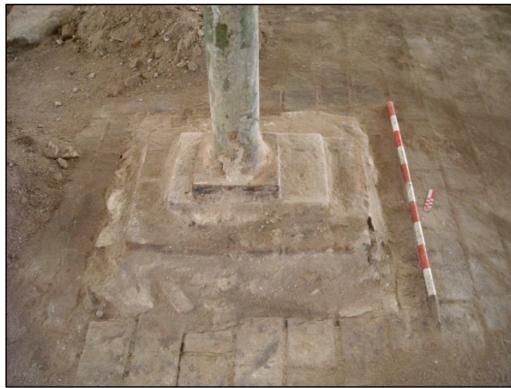
Detall del basament UE: 209 d'un dels pilars de fosa que sustenten la coberta de la Nau 2
