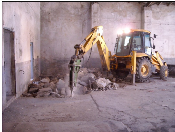
Detall del procés d'extracció de la solera UE 101 de la Nau 3
