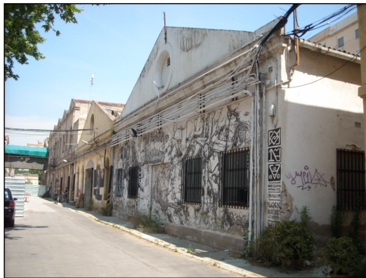
Vista general de la façana de la Nau 3 abans d'iniciar-se els treballs
