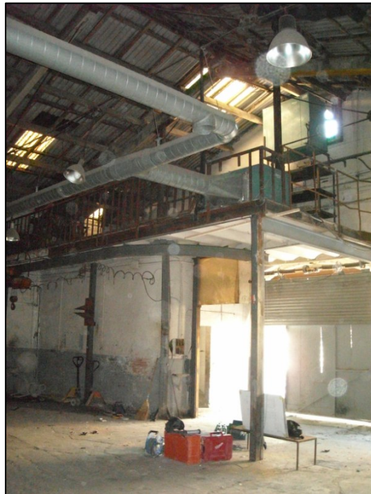
Vista general de l'altell de la Nau 3
