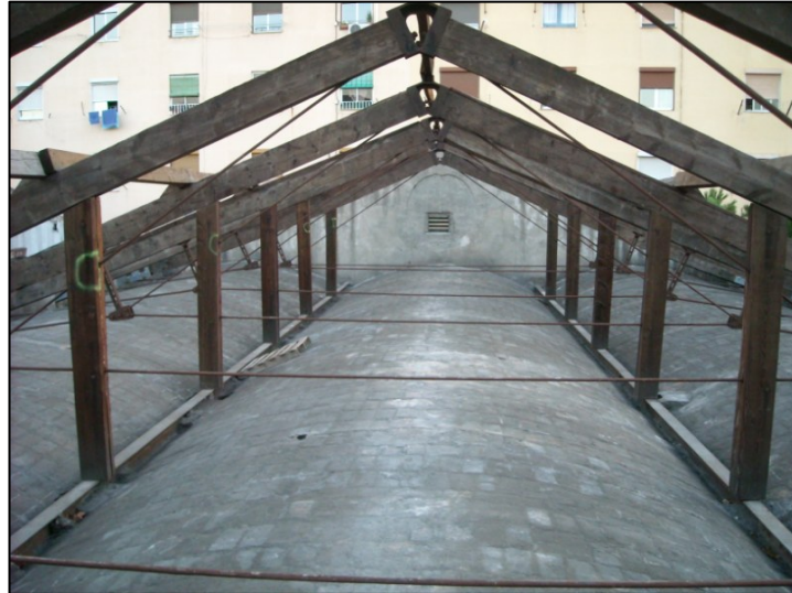
Vista general de l'encavallada de la Nau 3
