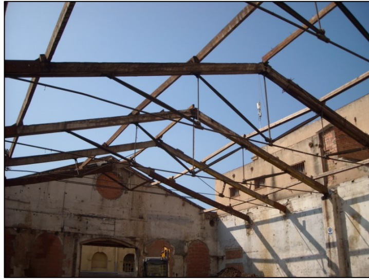
Vista general de l'encavallada de la Nau 3
