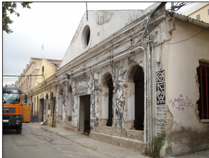
Vista general de la façana de la Nau 3 un cop realitzada la demolició dels elements afegits
