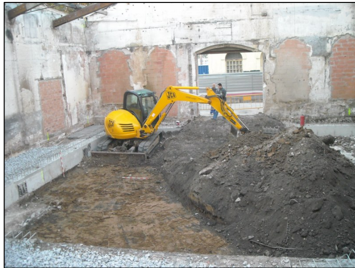
Vista general del procés d'excavació del soterrani de la Nau 2
