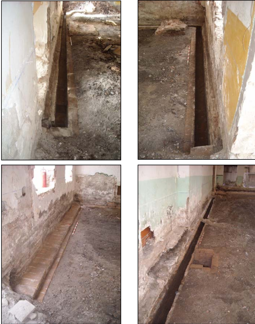
Vistes generals dels trams de canalitzacions UE 224, 227, 230
