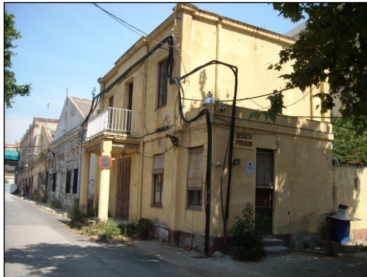
Vista general de la casa del porter abans d'iniciar-se els treballs
