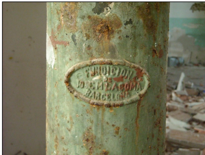
Detall d'un dels pilars de fosa on es pot observar la inscripció amb el nom de l'empresa constructora
