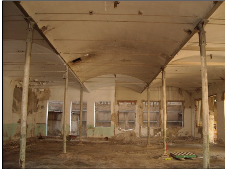
Vista general de la coberta o voltes de la Nau 3
