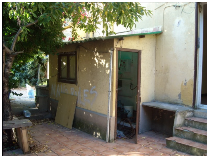
Vista general del volum annexat al parament posterior de la casa del porter
