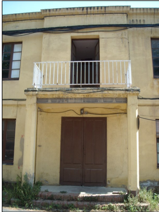
Vista general de l'entrada o accés a la casa del porter
