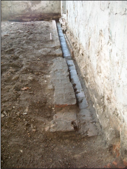
Vista general de la canalització UE 111
