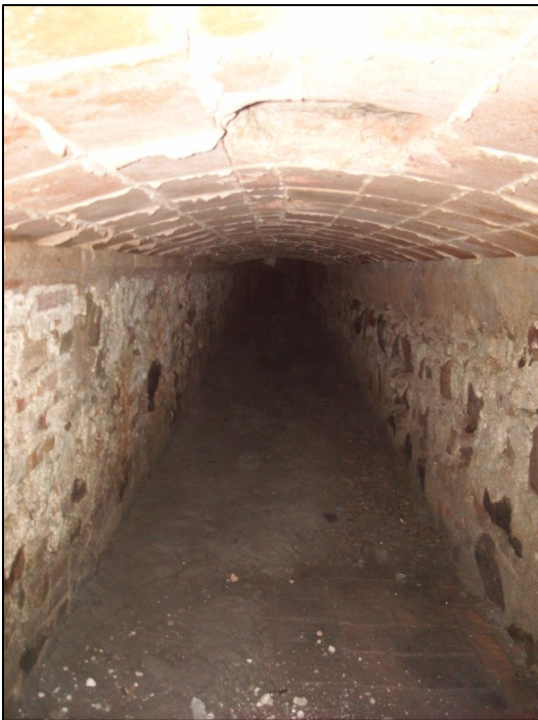
Detall de l'interior del col·lector UE 236
