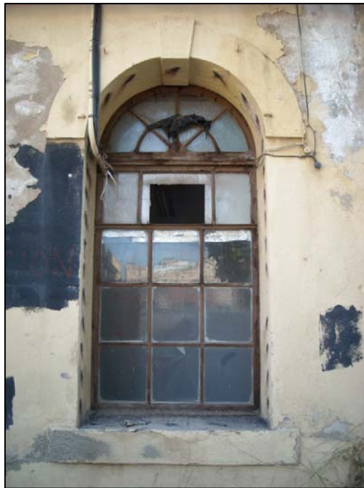
Detall d'una de les finestres de la façana de la Nau 2
