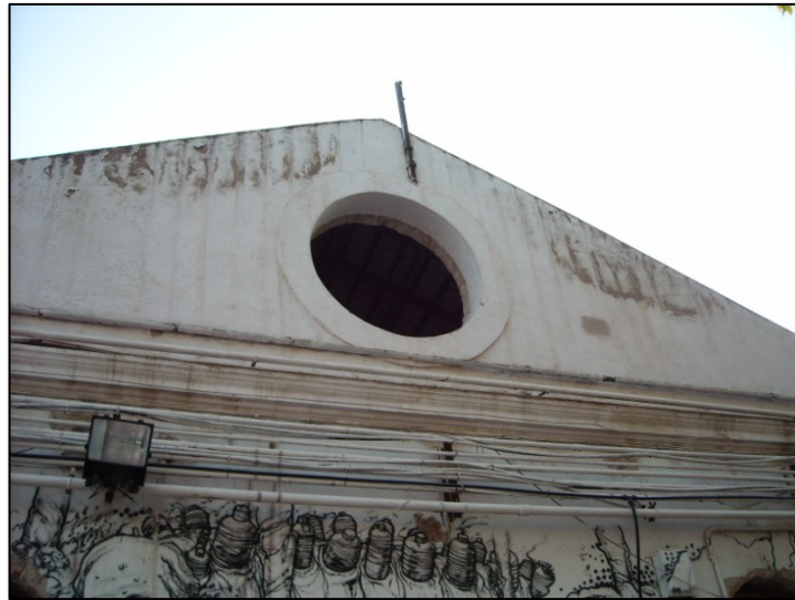
Detall de la claraboia situada a la part superior de la façana de la Nau 3
