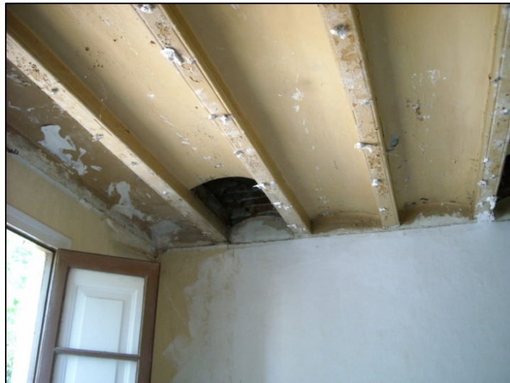
Detall del sostre o coberta original de les habitacions de la casa del porter
